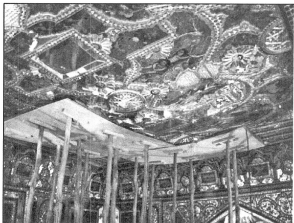
تصویر ۱۹- شمع‌بندی سقف
